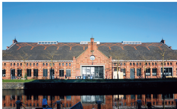
图 2 西煤气厂净化室外立面
