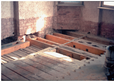
图8 仅在局部打开楼板,采用内窥镜技术检查建筑结构状况
