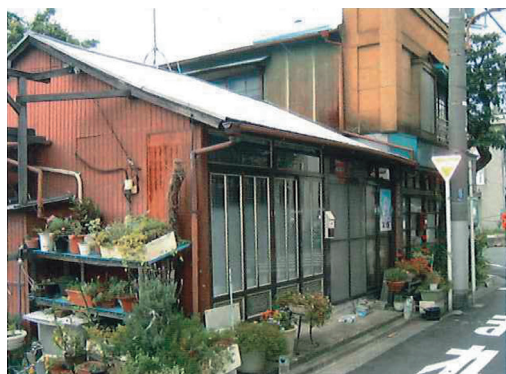
a 老旧独栋住宅
