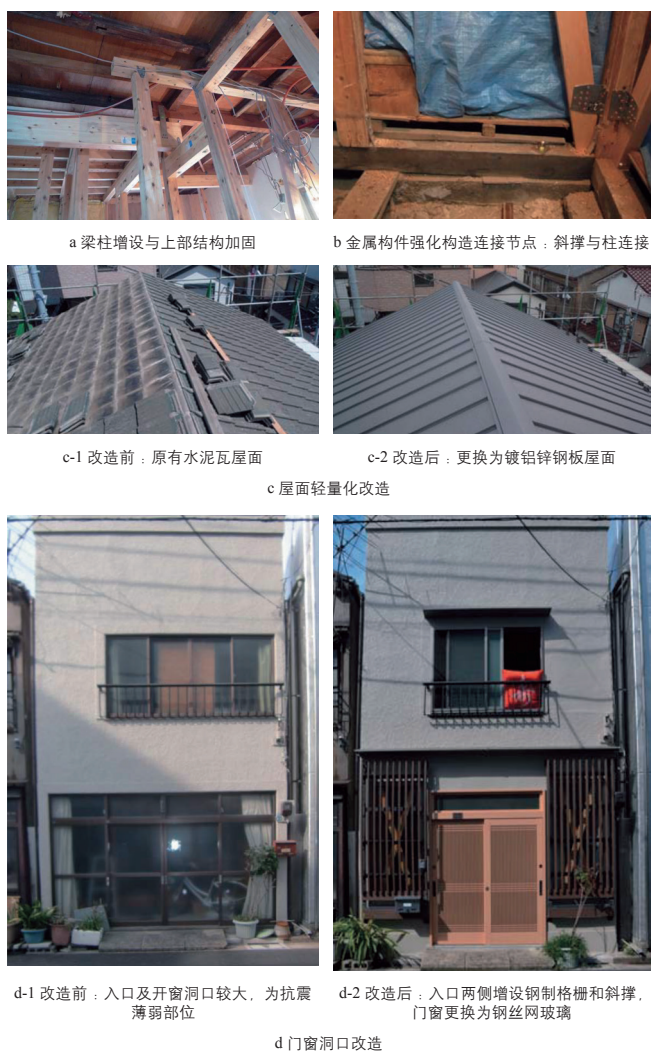
图 10 建筑抗震改造主要措施及示例
